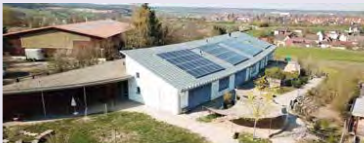
Der Kindergarten von der Gartenseite. Foto: Friedrich-Oberlin-Kindergarten
