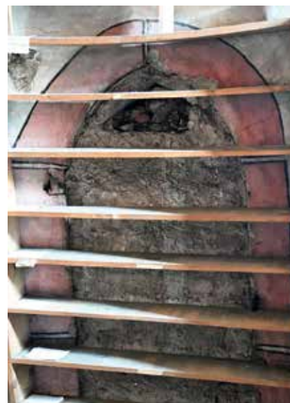
Die frühere Zugangstür direkt von außen wurde zugemauert und ist durch Bücherregale verdeckt
